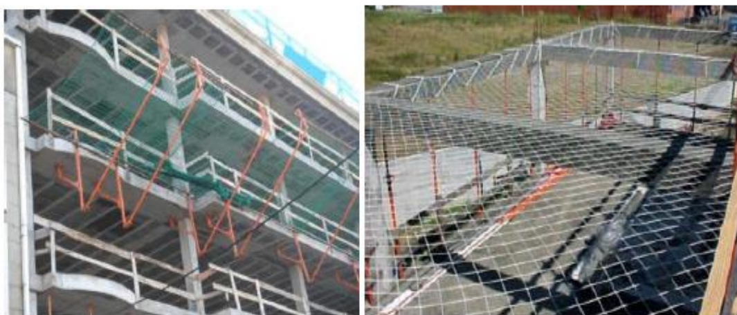
Figura 7.2 - Indicação das plataformas de proteção contra queda de funcionários
