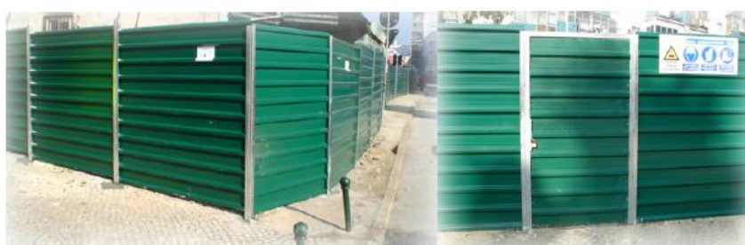
Figura 7.5 - Emprego de vedação metálica no nível térreo para resguardar o acesso a edificação em processo de demolição
