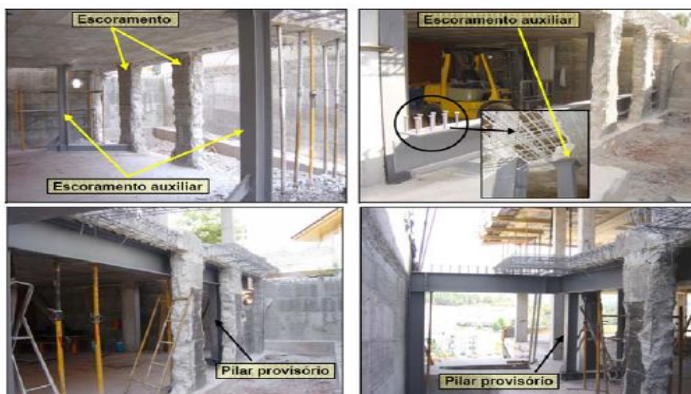
Figura 7.6 - Emprego de escoramento nas peças estruturais com instabilidade estrutural
