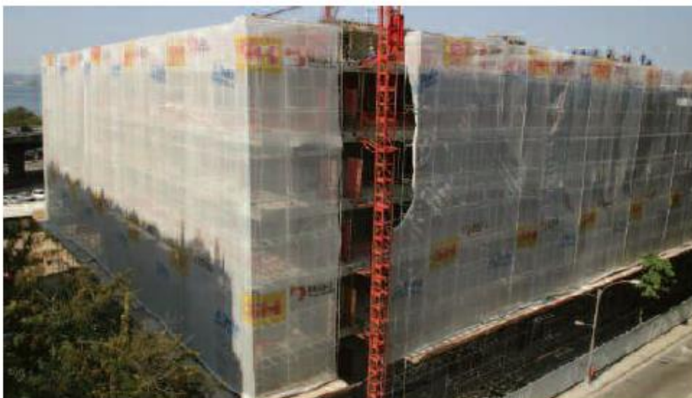
Figura 7.1 - Indicação da rede de segurança para evitar desmoronamento de resíduos sólidos
