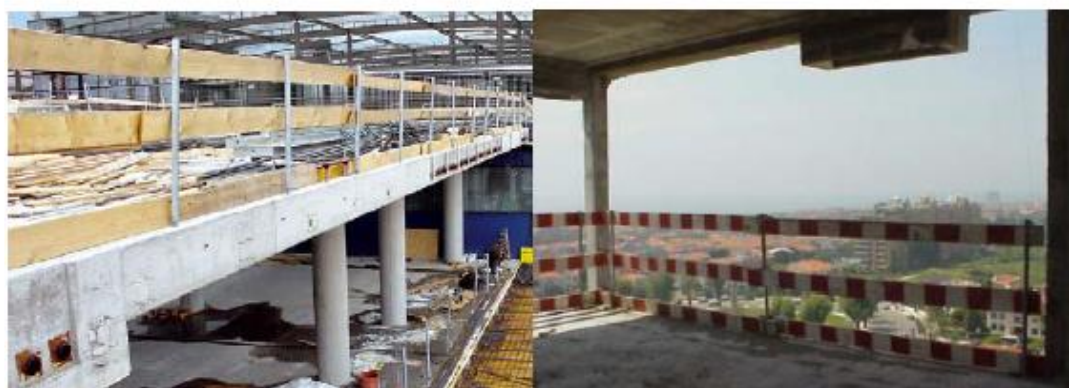
Figura 7.3 - Utilização de guarda-corpo para limitação da área de trabalho
